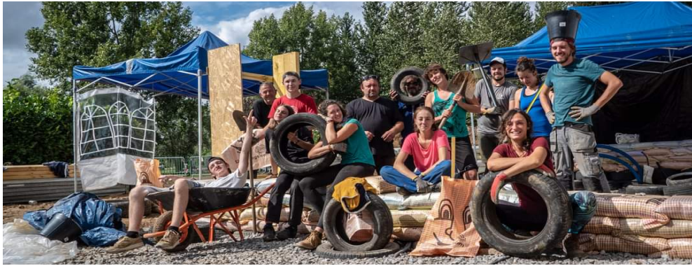
Chantier participatif dans le 62 France, construction d'un resto accueil bureau en superadobe Projet camping insolite, 40 participants sur 3 mois Lien journal France 3 : https://www.youtube.com/watch?v=diFaiYG7Hq0
